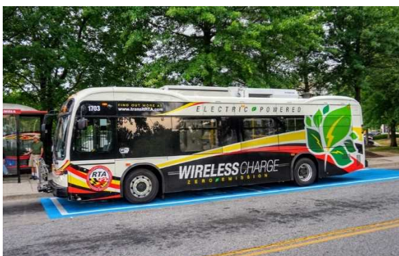
電気バスの50kW急速非接触充電状況（（ハワード郡）
