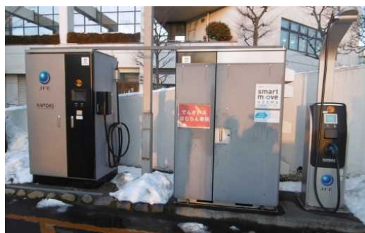
羽村市役所駐車場への設置
