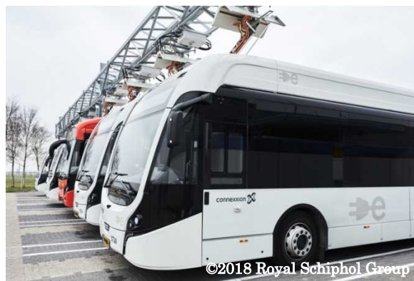
スキポール空港の充電施設
